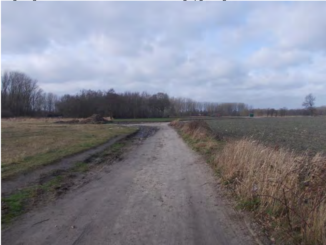
K. Oude Molenpad richting het westen gezien. Hier is nog iets van een bolling naar de zijkanten aanwezig. Verderop in de bocht is dit helemaal verdwenen en lijkt recent te zijn vergraven.
