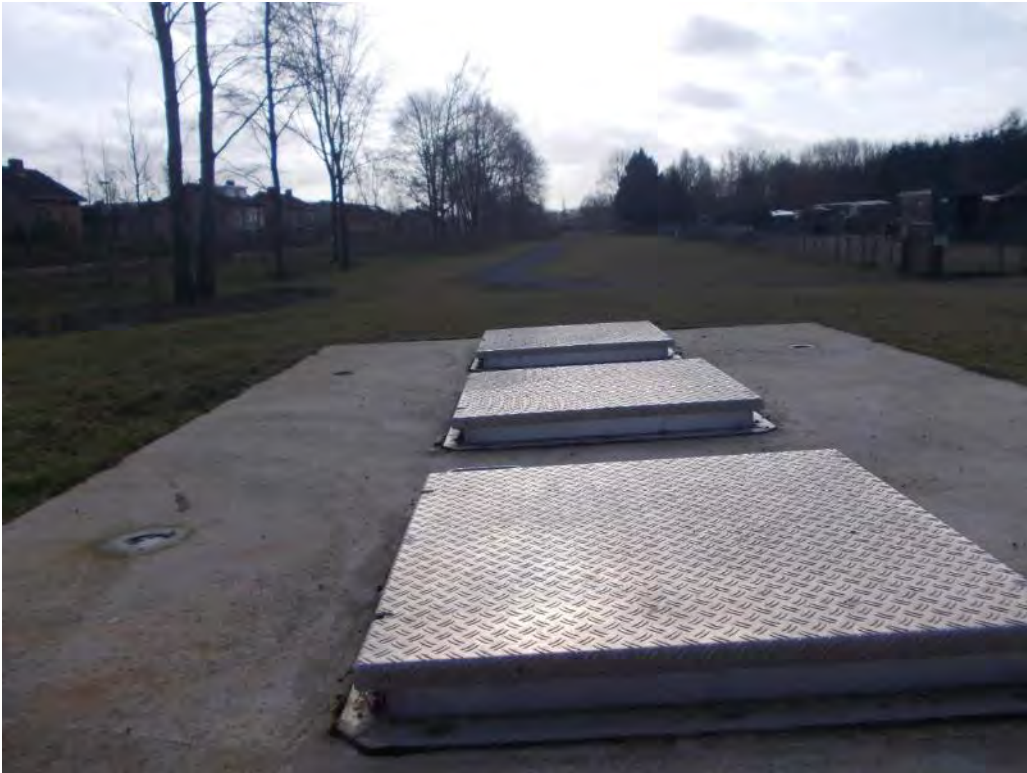
U: Een recent aangelegde grote leiding voor afvoer van overtollig regenwater loopt langs de westzijde van De Weegbree en Het Gegraaf door onder het fietspad richting Hoppenbrouwers.
