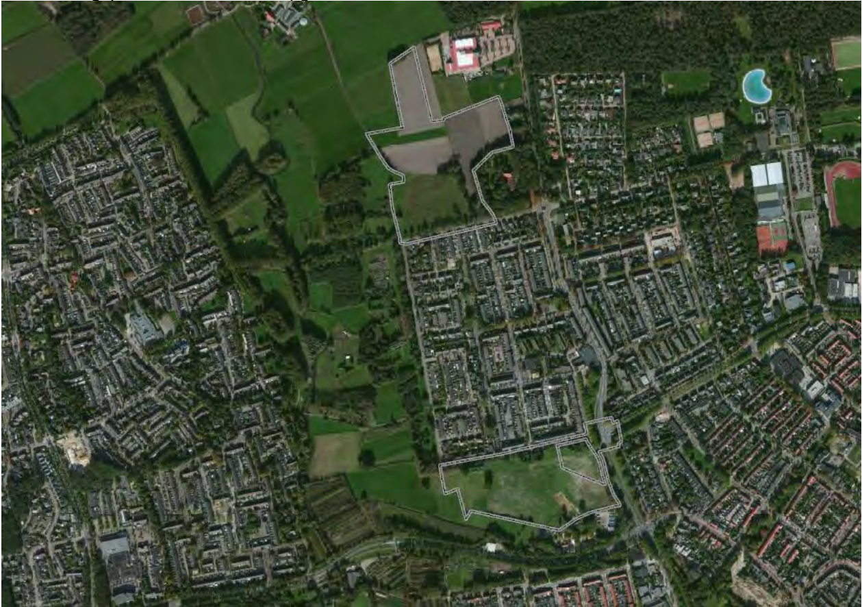
Afbeelding: Luchtfoto met daarop de deelgebieden Weegbree in het noorden en Hoppenbrouwers in het zuiden (bron: Google Maps).
